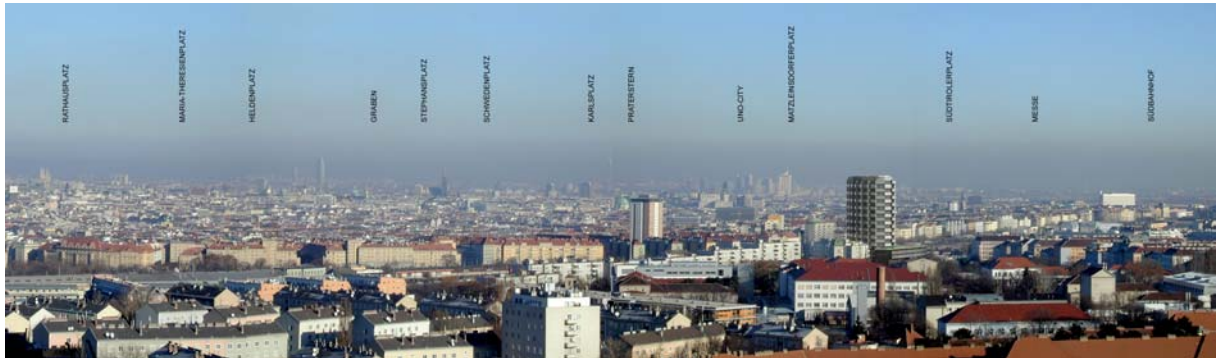
Blick vom Wienerberg zum Stadtzentrum mit Montage Hochhaus Kundratstrasse Rendering: Zdenkovic-Gold/ARTEC ARCHITEKTEN
