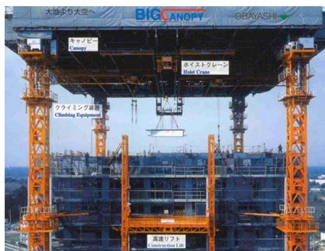
Abbildung 1a, b: automatische Bauverfahren in Japan
