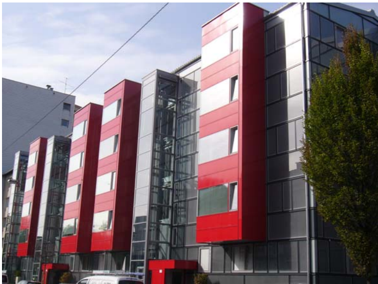
Abb. 4 und 5: Sanierung der Wohnhausanlage Makartstraße in Linz mit vorgehängten Fassadenelementen. Fertigstellung 2006 (Fotos: Hüttler)
